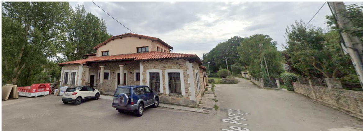
Antiguo Matadero frente a las parcelas del estudio de detalle, actual equipamiento público
